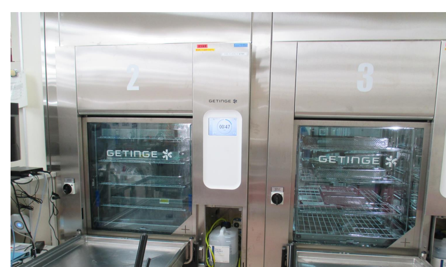
自動洗浄装置で洗浄と 熱水消毒をします
